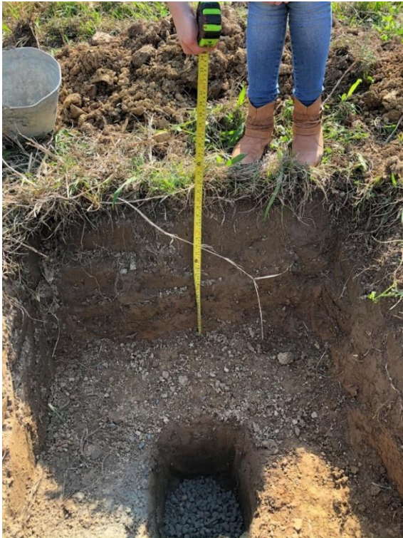
Figura 2 - Conferência da profundidade da cava maior (imagem meramente ilustrativa).
