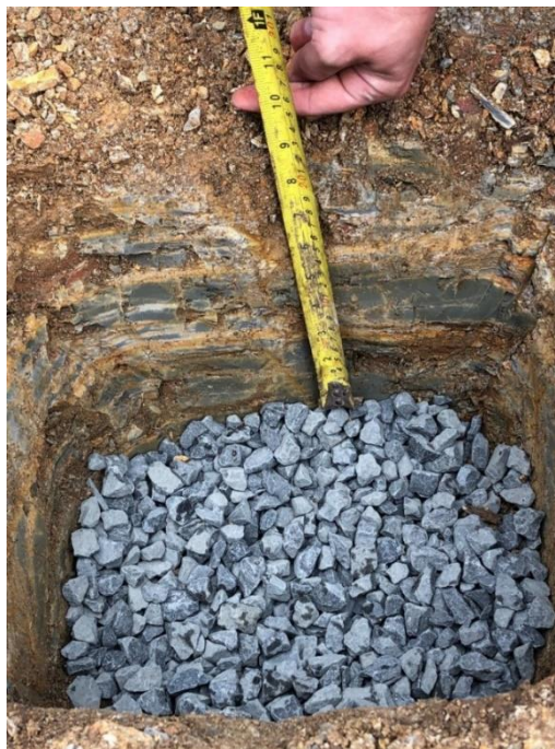
Figura 4 – Conferência da espessura da camada bruta (imagem meramente ilustrativa).
