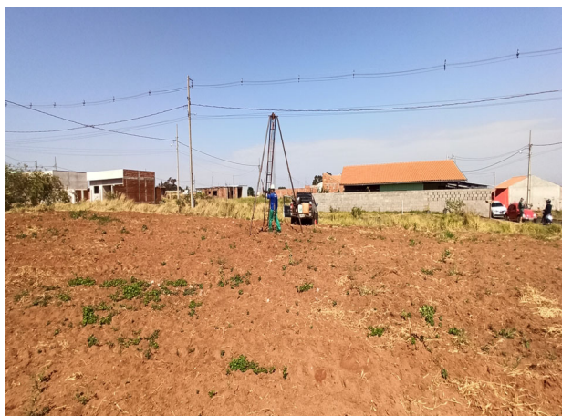
FOTO 4 - SONDAGEM A PERCUSSÃO
