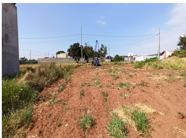
FOTO 5 - SONDAGEM A PERCUSSÃO
