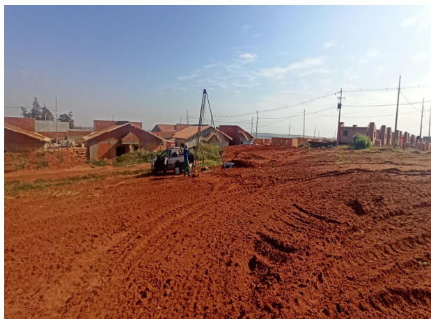
FOTO 1 –SONDAGEM A PERCUSSÃO
