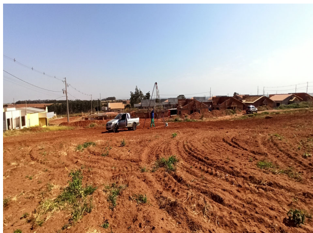
FOTO 2 - SONDAGEM A PERCUSSÃO
