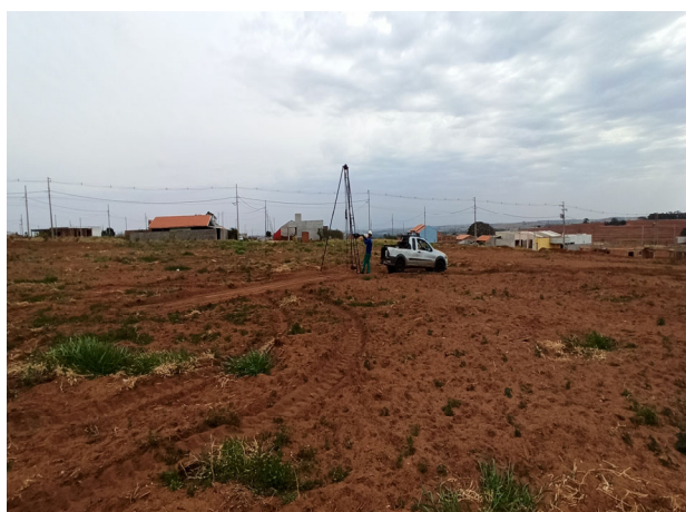
FOTO 6 - SONDAGEM A PERCUSSÃO
