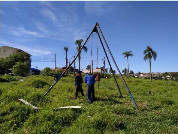
Figura 1 - Execução do serviço de sondagem
